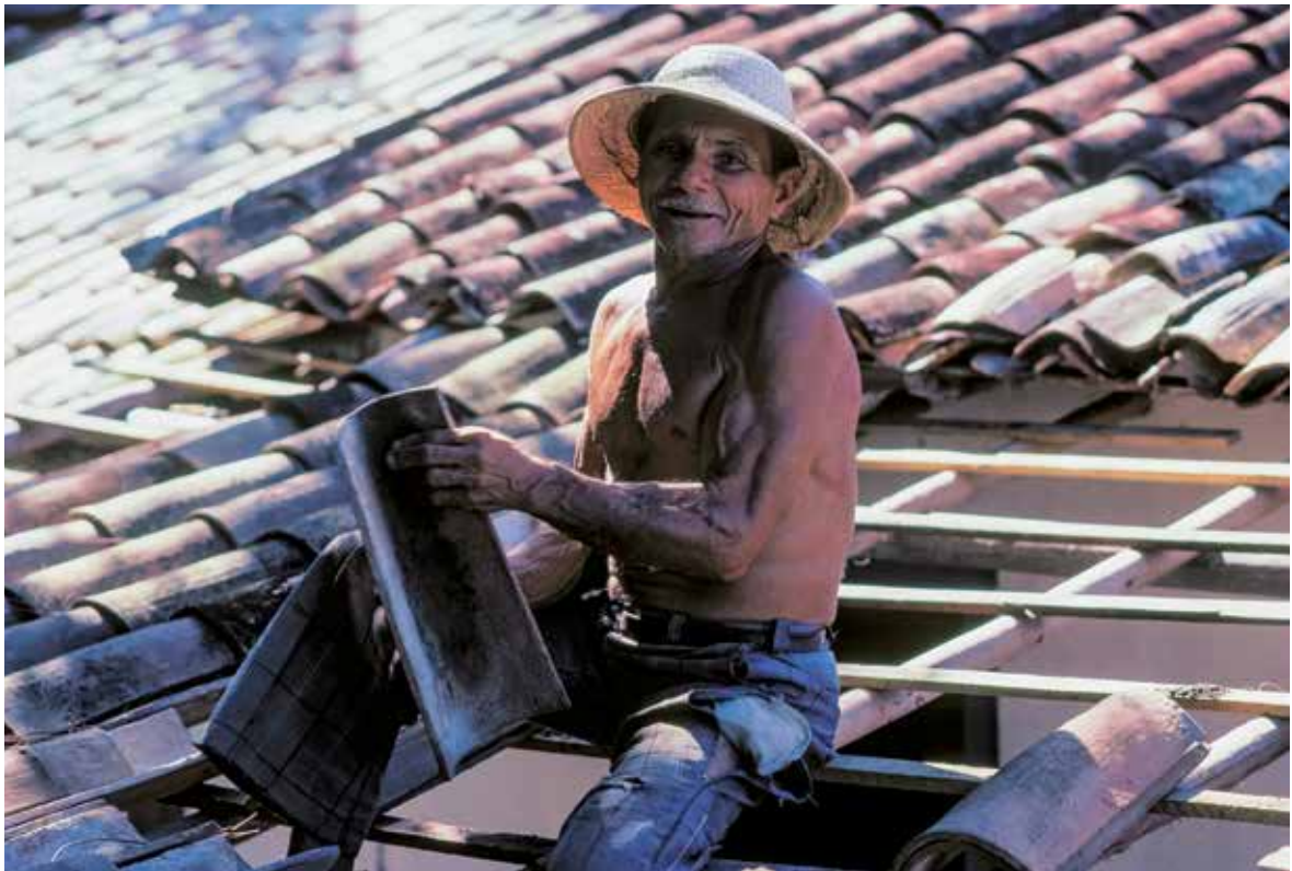
Enedino consertando telhado. Trancoso, BA 1984
